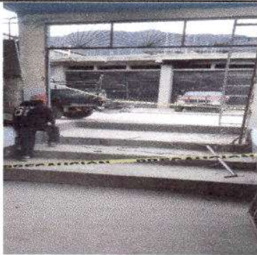
Foto7: En proceso de sustitucion de puerta de metal.
