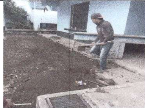
Foto 12: En proceso de reparacion de piso de torta de concreto.
