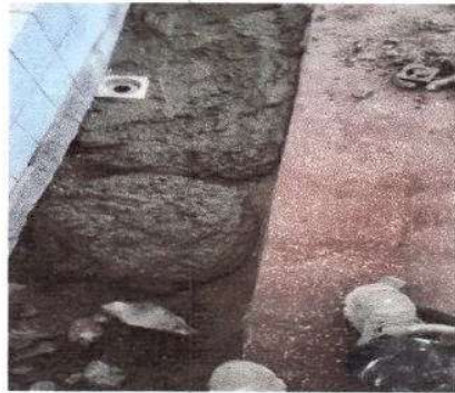
Foto 4: En proceso de reparación de red de drenaje y red de agua potable.
