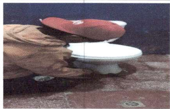
Foto 10: En proceso de sustitucion de inodoro.
