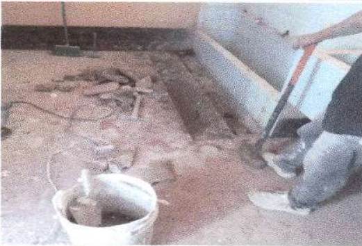
Foto 3: En proceso de reparación de red de drenaje y red de agua potable.
